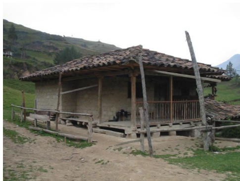
Figura Nro.12: Vivienda Vernácula de San Lucas. Fotografía de los autores
